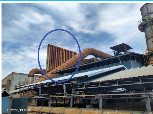
รูปที่ 3-5 ระบบ Natural Cooler ที่ติดตั้งเพิ่มเติม
