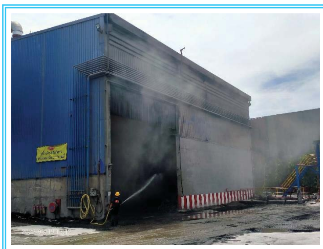
รูปที่ 3-9 อาคารเท Slag ติดตั้งระบบฉีดพรมน้ำ, ม่านกันฝุ่น
