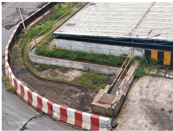
รูปที่ 3-32 บ่อเก็บรวบรวมน้ำจาก Sludge เพื่อส่งไปยัง Irrigation Pond และนำกลับมาหมุนเวียนใช้ใหม่
